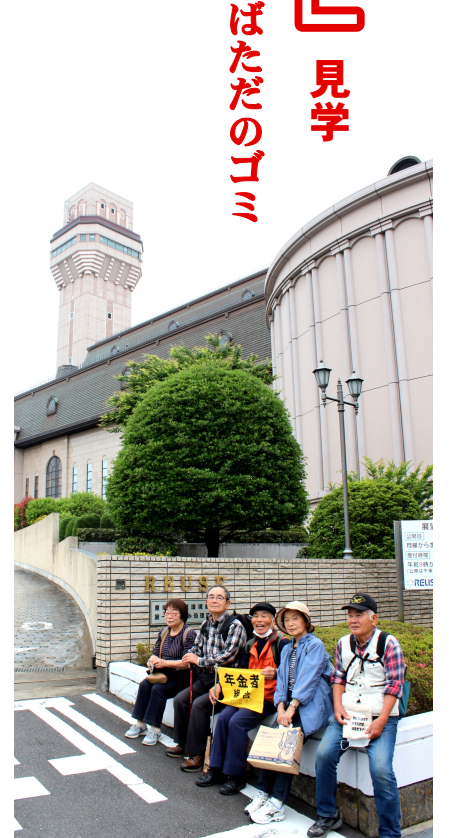
第1工場ごみ処理施設
